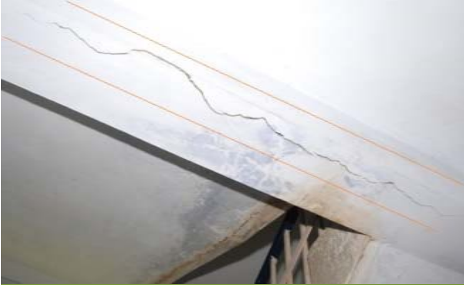
Fig a. Longitudinal crack in beam
